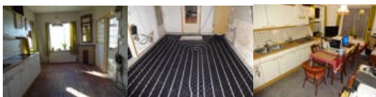
Keuken voor, tijdens en na de werkzaamheden.
