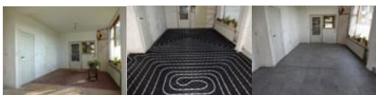
Woonkamer voor, tijdens en voorlopig na de werkzaamheden.
