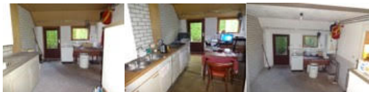
Bijkeuken voor, tijdens en na de werkzaamheden.
