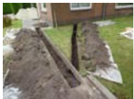
Eerst de telefoon en internetkabel via een mantelpijp onder de nog aan te leggen betonvloer opnieuw invoeren.
